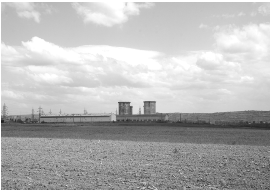
Stația de compresoare
