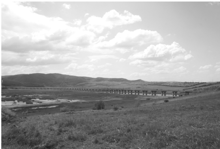
Viaductul de la Suplacu de Barcău
