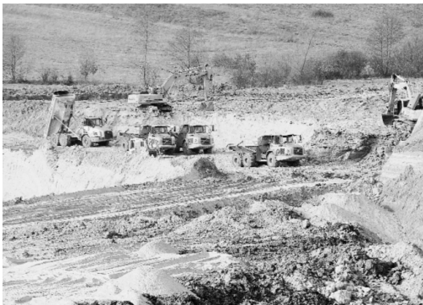
Exploatarea de suprafață a cărbunelui a reînceput în 2008
